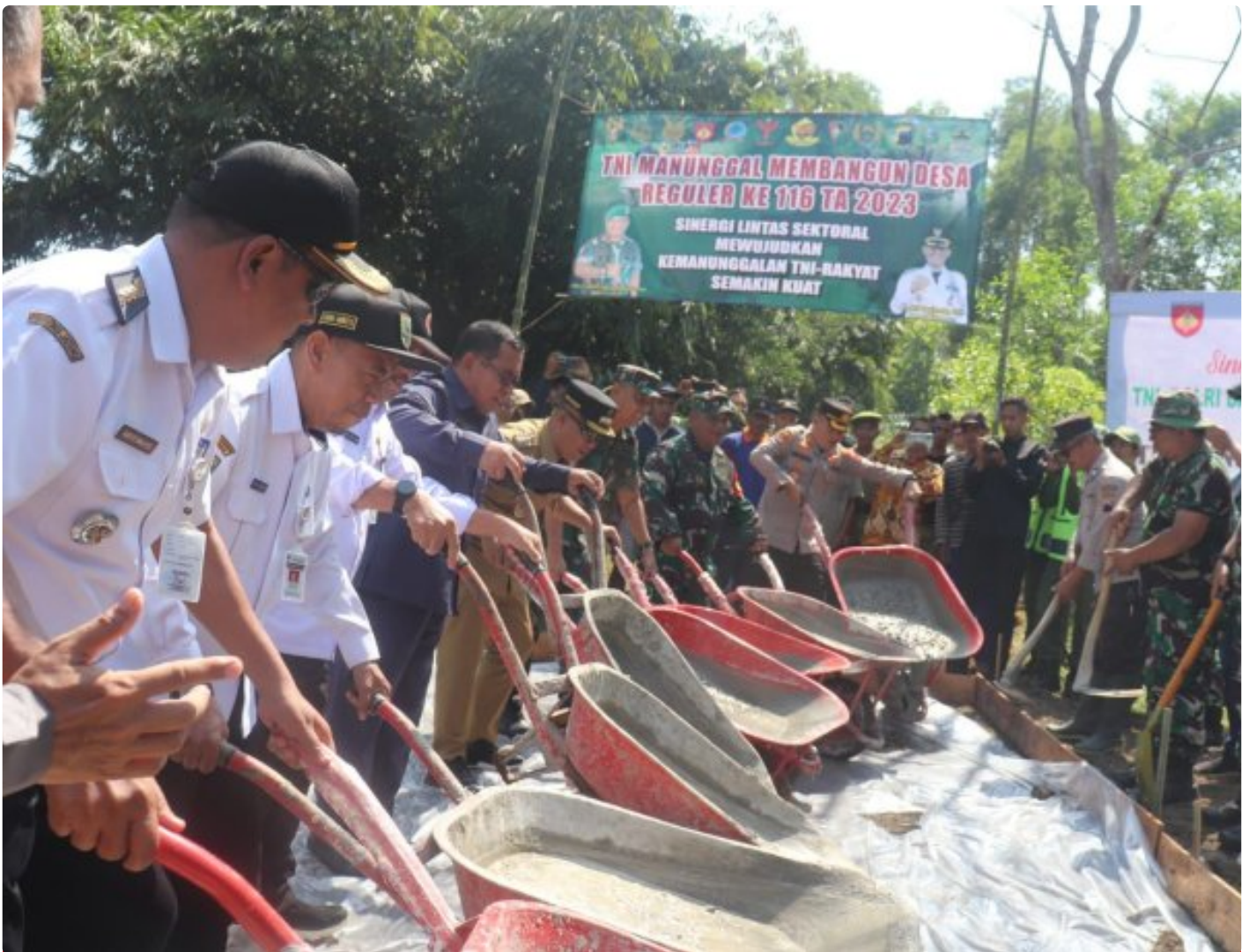
Peletakan Batu Pertama Sebagai Simbolis Pengerjaan Jalan TMMD Reguler ke-116 Kodim 0709/Kebumen di Desa Pejengkolan, Kecamatan Padureso, Kabupaten Kebumen, Jawa Tengah
