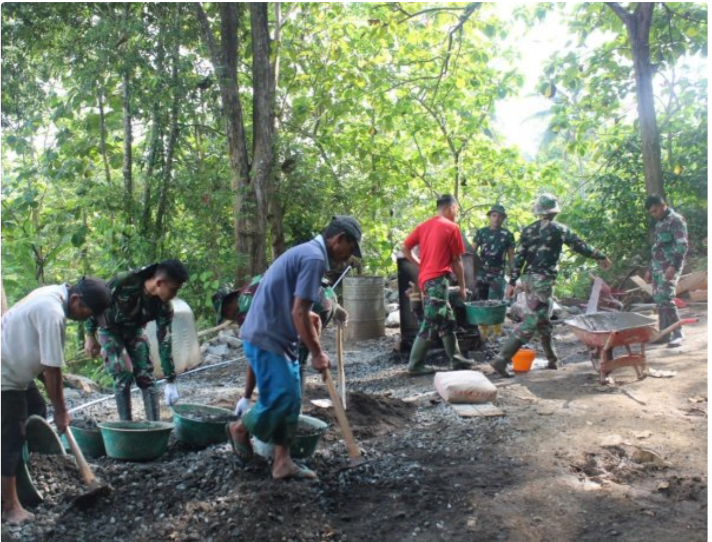
Hari Pertama Mulai Menggarap Pengerjaan Pengecoran Jalan Secara Bergotong Royong Bersama Masyarakat
