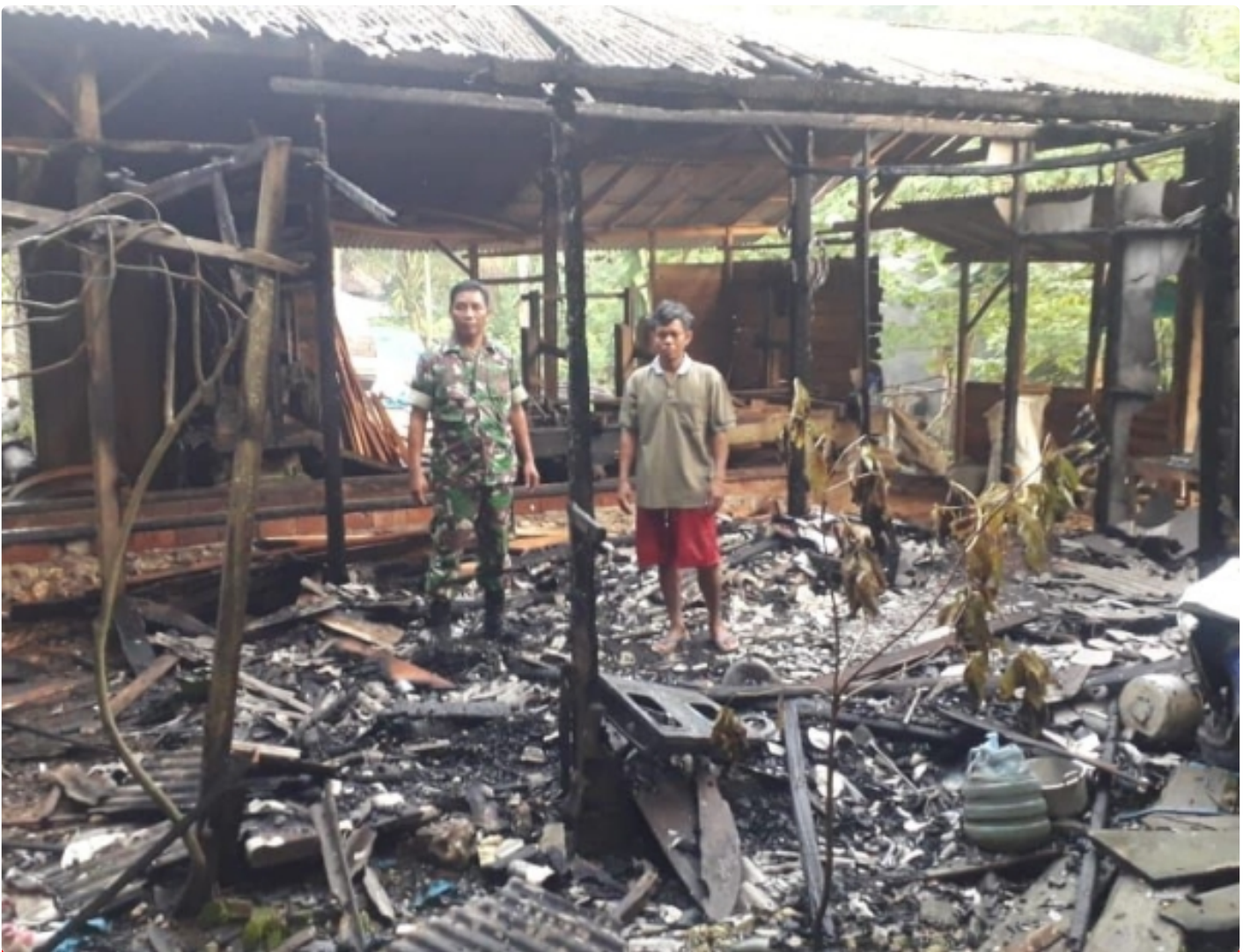
Babinsa Koramil 20/Buayan Bantu Warga Bersihkan Puing Kebakaran Rumah Warga
