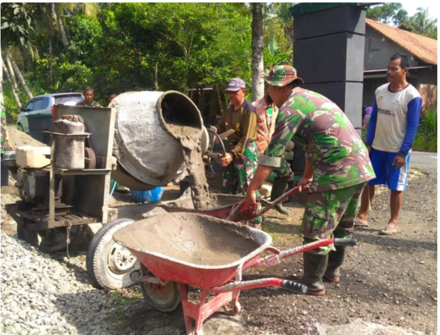
Anggota Posramil Bonorowo Bantu Warga Pengecoran Jalan
